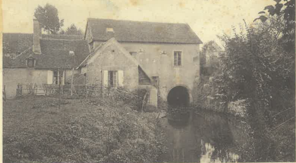
6217. SAINT-REMY-DES-MONTS (Sarthe) — La Dive à Feu Richard (ancien Moulin)
